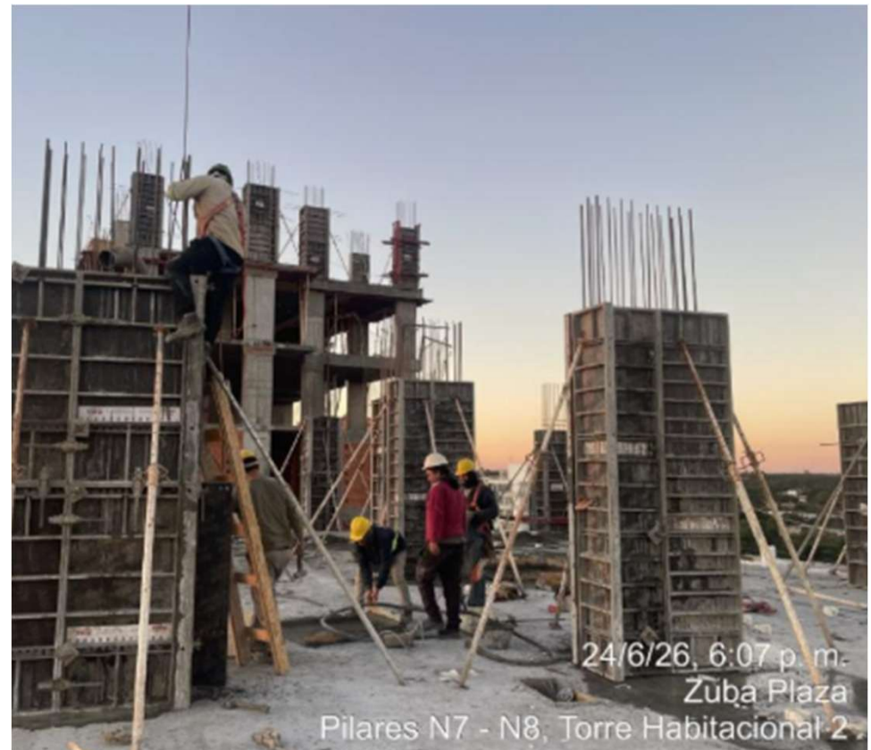
Cargamento de losa N7 – Cargamento de pilares N7-N8
