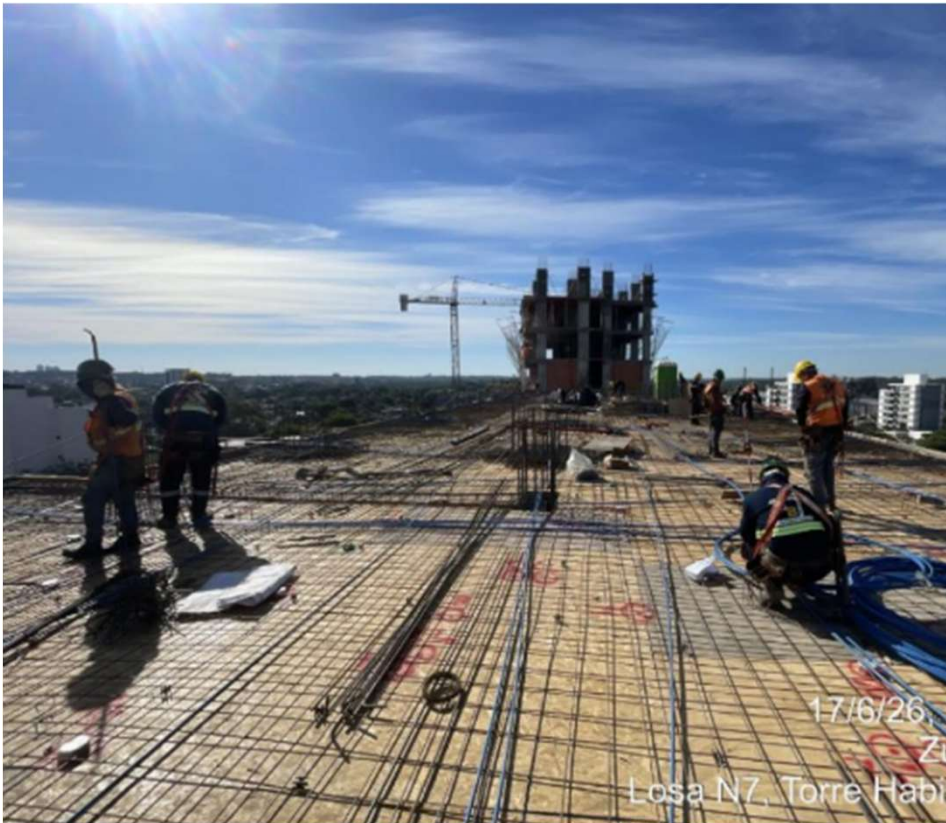
Encofrado y armado de losa N7 – Elevación de mampostería en N1
