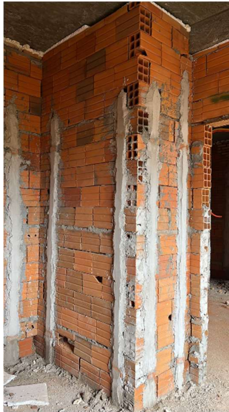
Fajas para revoque y ducteado de IE en N1 y N2
