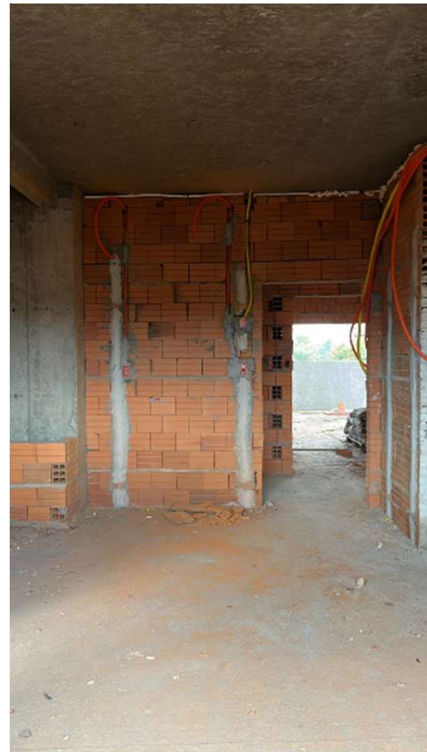
Fajas para revoque y ducteado de IE en N1 y N2
